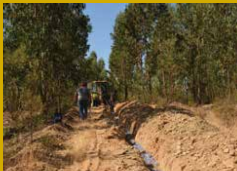
• Execução da conduta de abastecimento de água da Atalaia para a Serrasqueira
