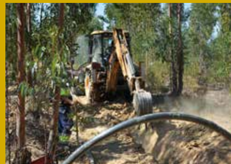
• Execução da conduta de abastecimento de água da Atalaia para a Serrasqueira
