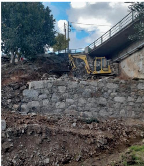
O Município de Vila Velha de Ródão promoveu a realização de uma empreitada destinada a garantir a reconstrução de muros de suporte no talude da ribeira do Enxarrique, junto à ponte na rua da Estrada, os quais tinham já sofrido uma derrocada, encontrando-se assim toda a estrutura do talude em risco de queda.
