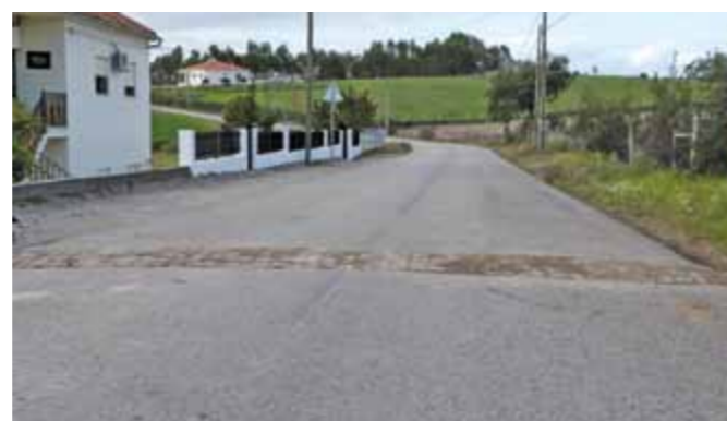
■ Construção de lombas em Cebolais de Baixo
