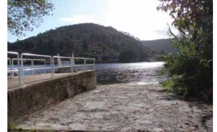
■ Construção de rampa em betão armado, para acesso ao rio Tejo, na zona do cais, em Vila Velha de Ródão
