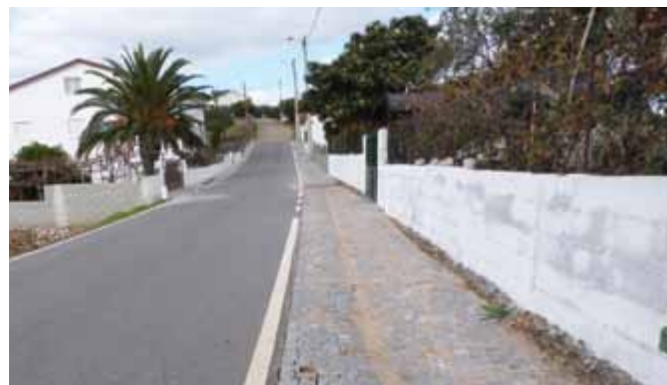
■ Construção de bermas e valetas em calçada de granito, na entrada sul da localidade de Serrasqueira
