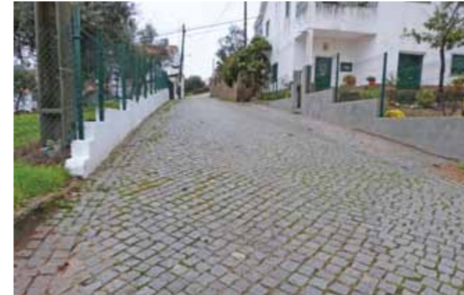
■ Repavimentação em calçada, nos locais da execução de ramais e outras reparações, em Peroledo
