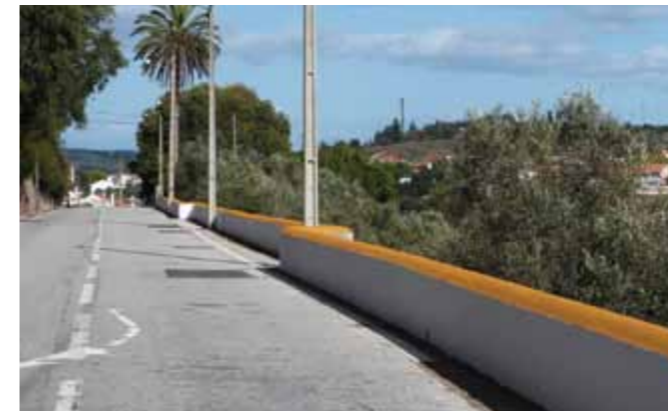
■ Reconstrução de muro de suporte à Estrada Nacional 18, perto da ponte sobre o rio Tejo
