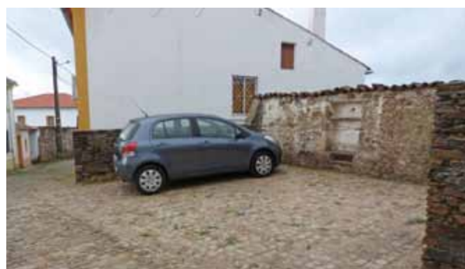
■ Demolição de casa degradada, na localidade de Gardete e calcetamento do espaço, criando lugares de estacionamento
