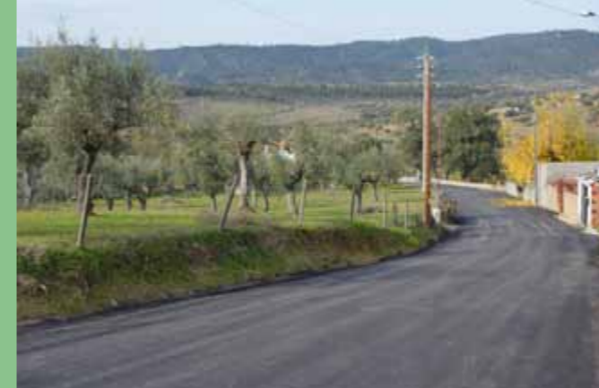
Pavimentação da Rua do Ribeiro em Vale de Pousadas
