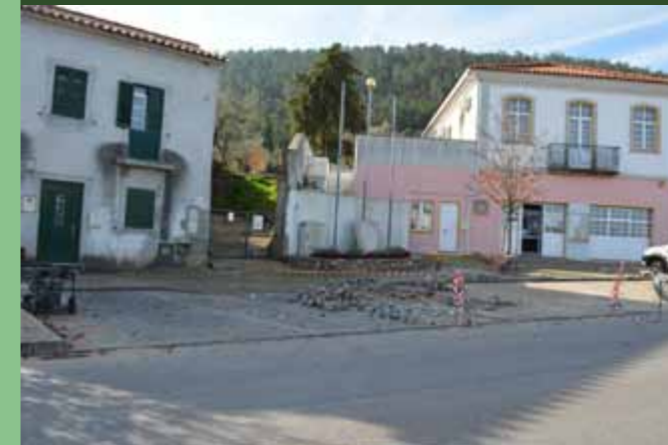
Repavimentação de estacionamento em V. V. de Ródão
