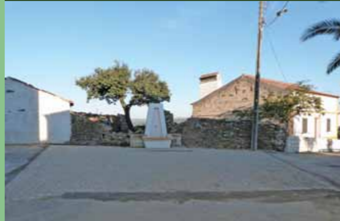
Repavimentação de calçada em Silveira
