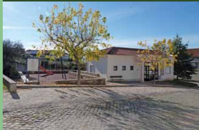
Remodelação da zona envolvente ao Centro de Saúde de Perais que incluí a colocação do parque infantil
