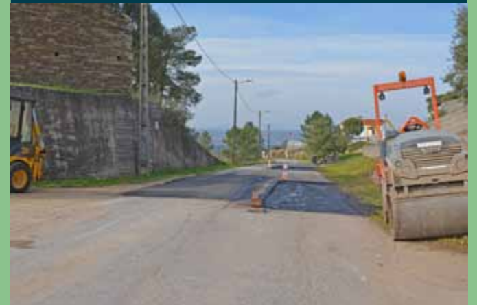
Reparação de pavimento na estrada de Monte Fidalgo
