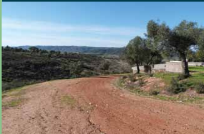
Trabalhos de beneficiação do espaço envolvente ao recinto da Senhora dos Remédios e dos caminhos de acesso
