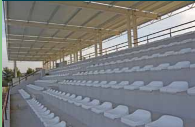
Cobertura das bancadas do Estádio Municipal e colocação de bancos individuais
