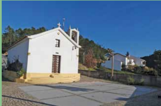
Demolição e construção de novo pavimento em frente à capela de Foz do Cobrão
