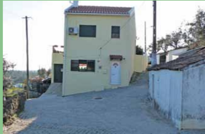
Repavimentação de calçada em Peroledo
