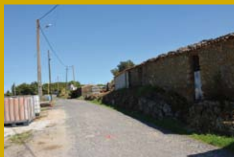
• Beneficiação do C.M. 1369 – Acesso à Riscada
