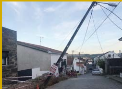
• Abertura de valas para instalação de eletricidade, fibra ótica e telecomunicações e reposição de calçada.
