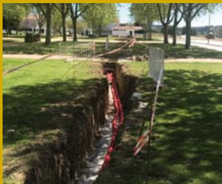
• Abertura de valas para instalação de eletricidade, fibra ótica e telecomunicações e reposição de calçada.
