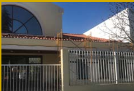
• Requalificação de caleiras e telhado do Jardim de Infância
